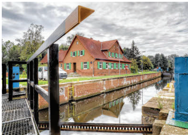
Fertig zur Übergabe: Die Technik zu Schleuse und Wehr wurde aus dem Schleusenwärterhaus in den Betriebsschuppen im hinteren Teil gebracht. Die Bima könnte das Gelände veräußern. FOTO: GEOS
