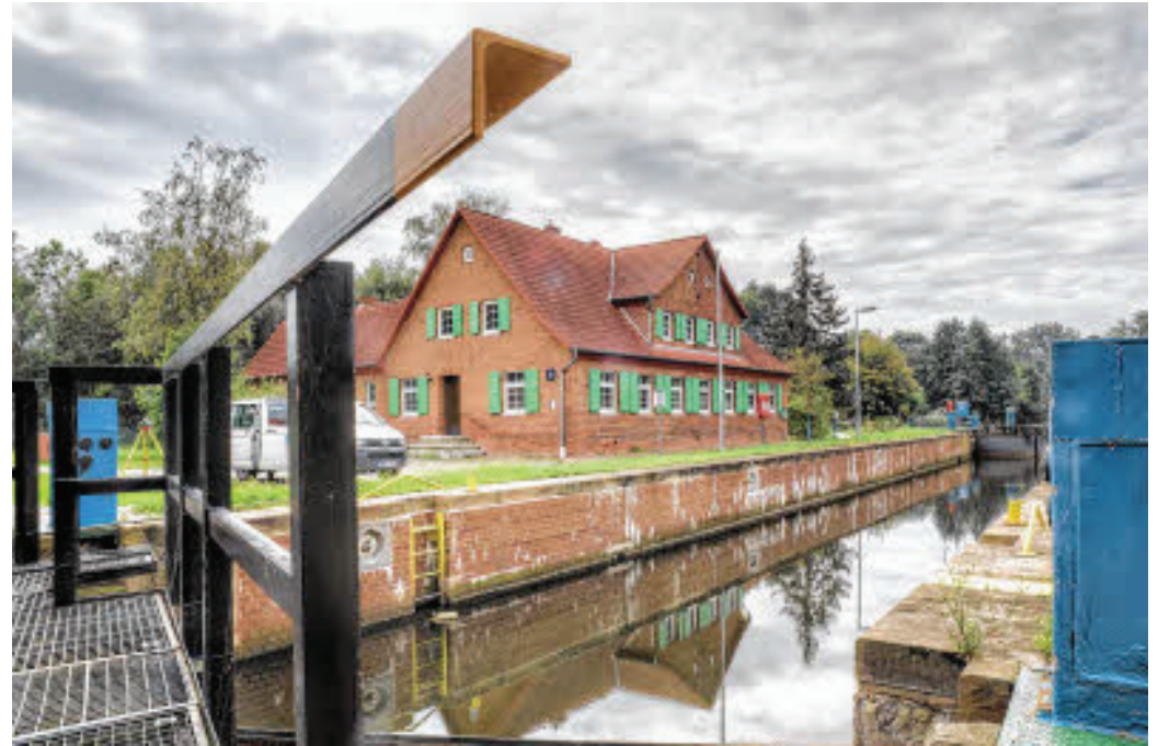
Die 1887 erbaute Schleuse könnte bald zum technischen Denkmal werden.
