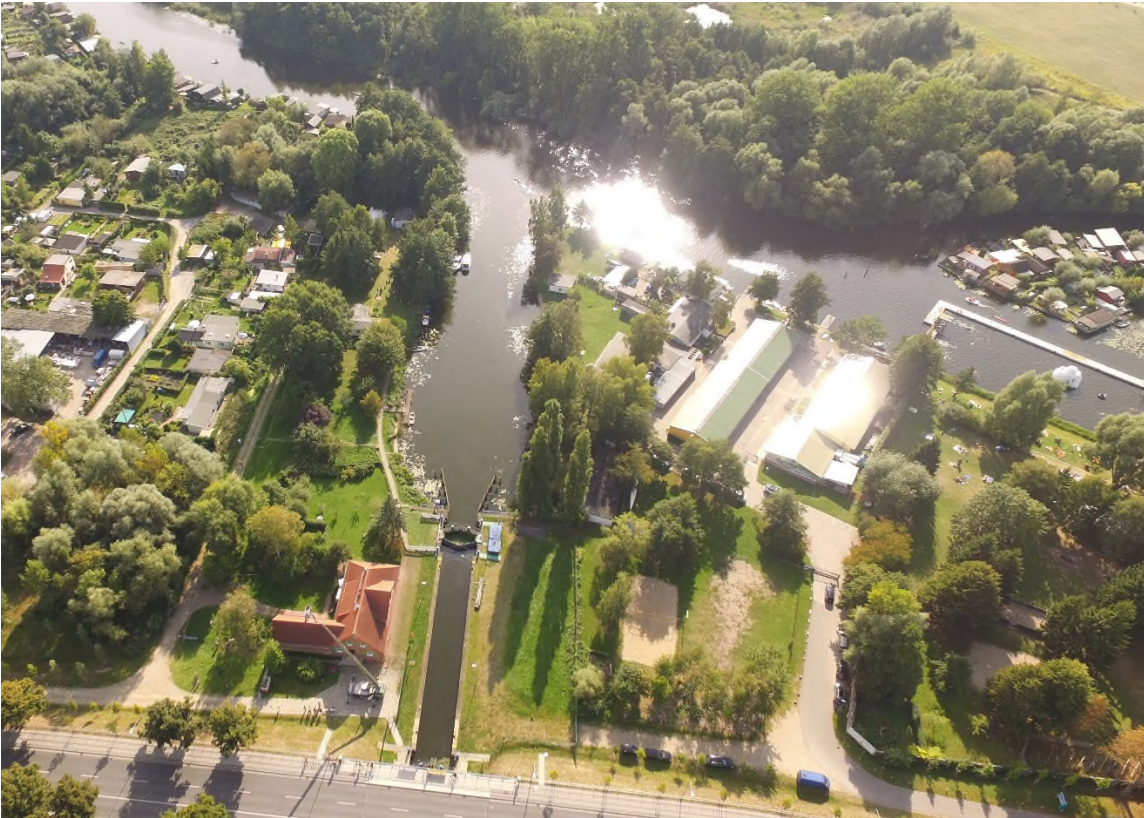
Abbildung 1: Schleuse und Schleusengelände
