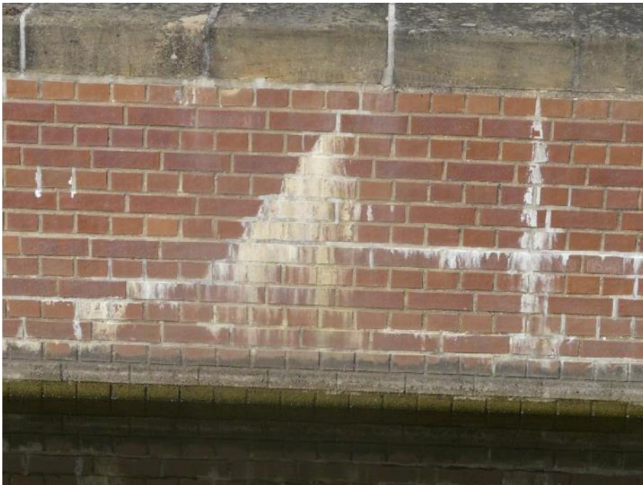
Abbildung 10: Aussinterungen an Kammerwänden
