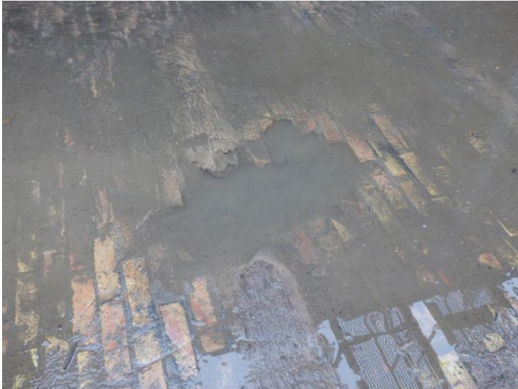
Abbildung 12: Fehlstelle Kammersohle
