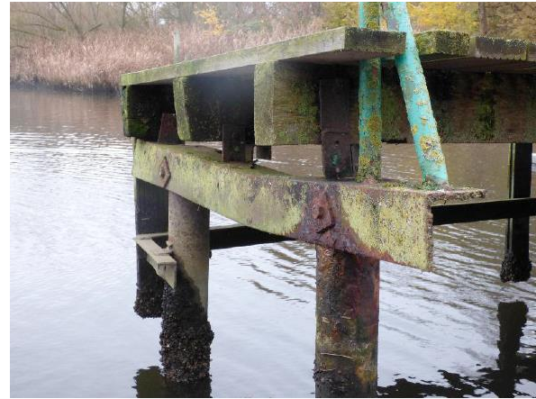
Abbildung 21: Leitwerk am Unterhaupt
