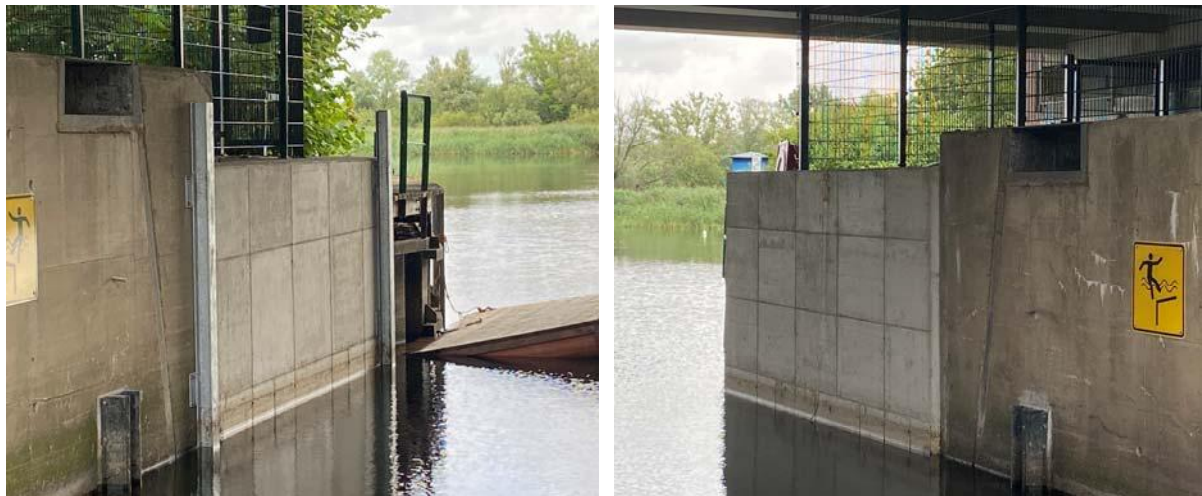
Abbildung 42: Sanierte Kammerwände Oberhaupt (Juli 2021)
