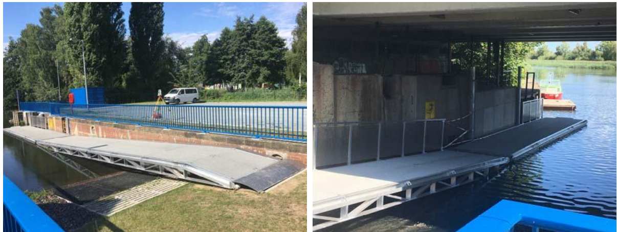
Abbildung 41: Schwimmsteganlage der Bootsschleppe (August 2021)
