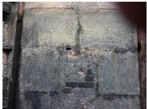
Abbildung 14: Mauergefüge am Oberhaupt
