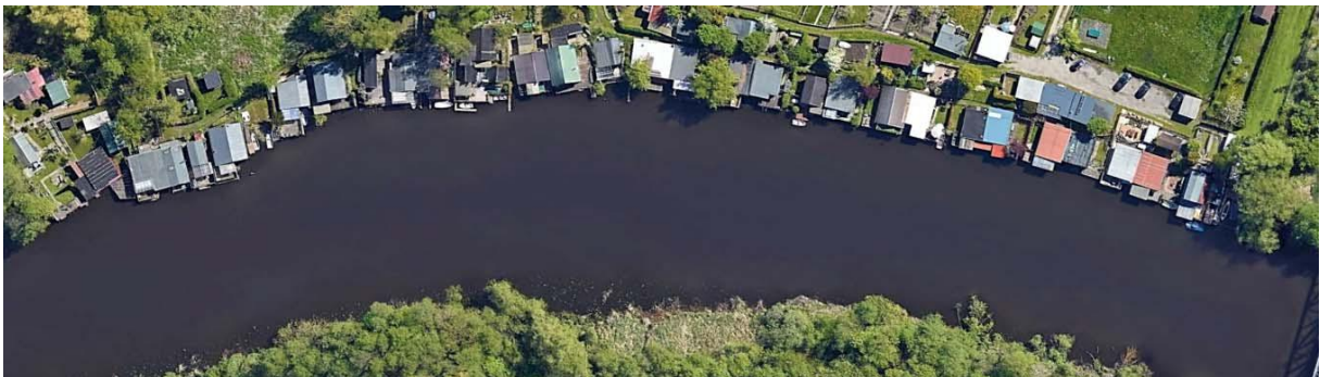
Abbildung 45: Uferbebauung südliche der Mühlendammwehrla Schleuse vor der Geinitzbrücke
