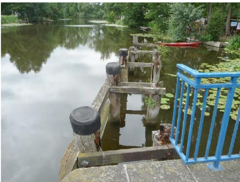
Abbildung 19: Ehemaliges Leitwerk am Oberhaupt
