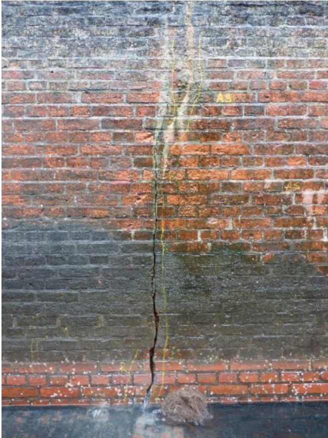
Abbildung 11: Wasserführender Vertikalriss
