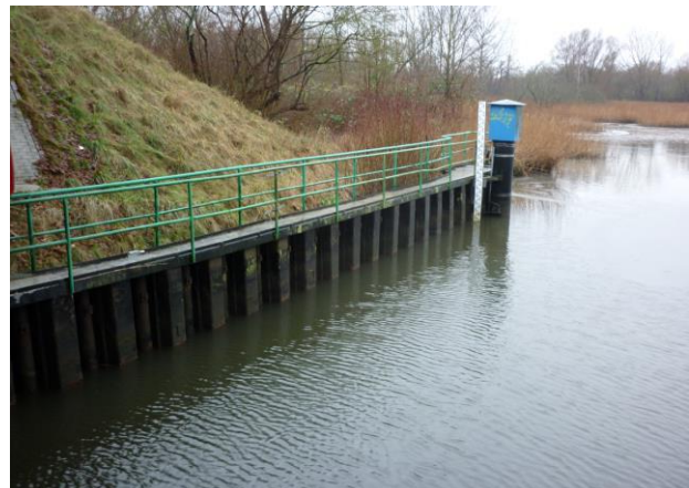
Abbildung 7: Leitwerke am Unterhaupt, Ansicht
