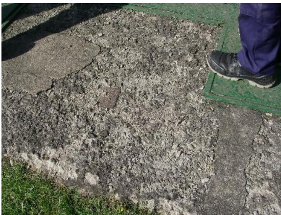
Abbildung 13: Betonoberfläche am Oberhaupt
