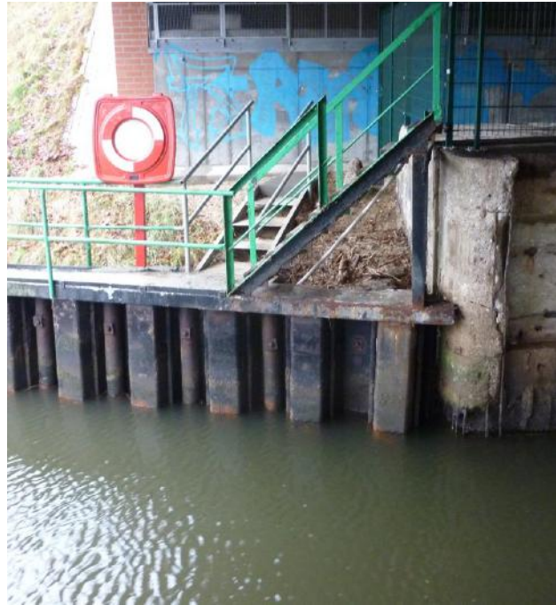
Abbildung 5: Unterhaupt - eingebaute Flügelwände
