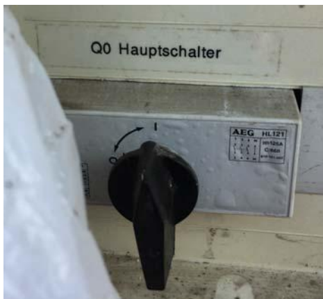
Abbildung 33: Hauptschalter Hausanschluss
